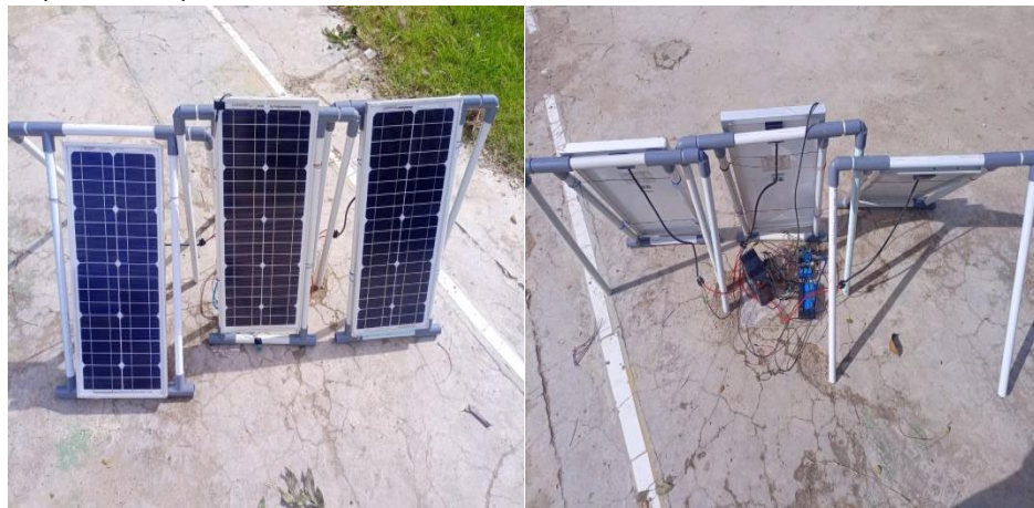
Gambar 5. Instalasi system pengukuran efektivitas solar panel
